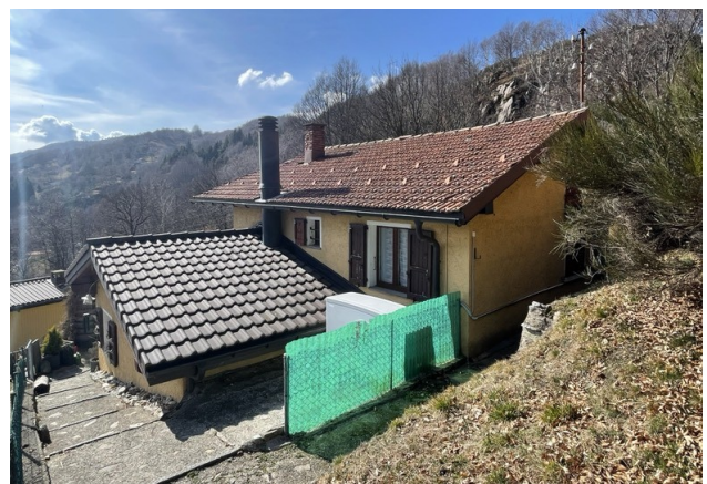
Ansicht aufs Haus vom Grundstückeingang
