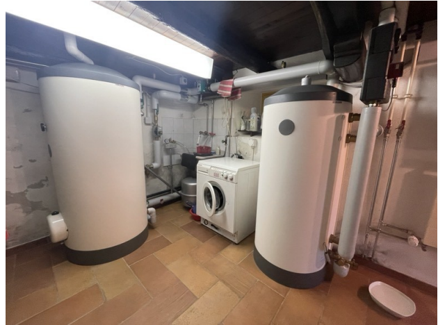
Waschküche / Technischer Raum «Casa»
