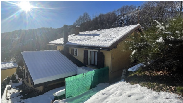
Ansicht aufs Haus vom Grundstückeingang
