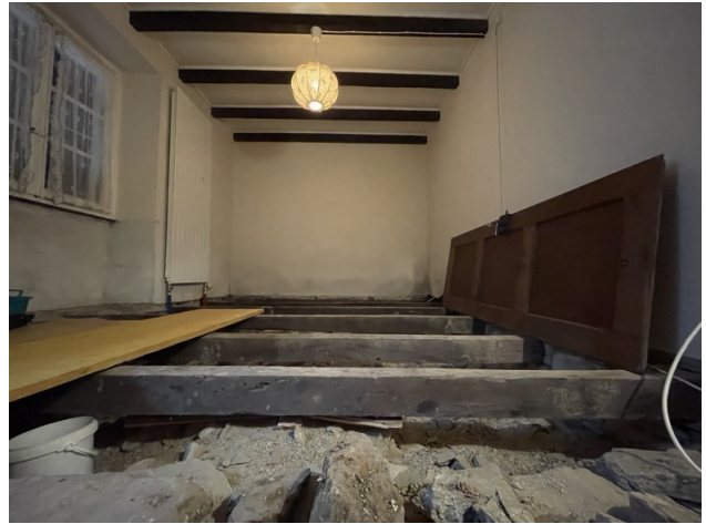
Zimmer 2 «Casa vacanza» momentan unbewohnt wegen Einbau der Zentralheizung
